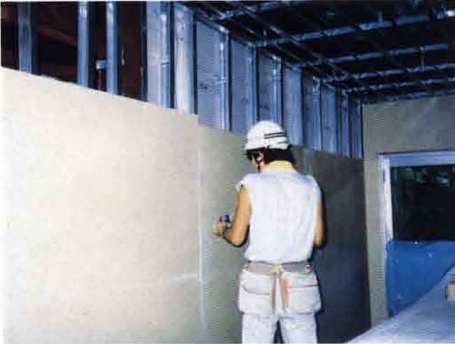
軽鉄間仕切工事
