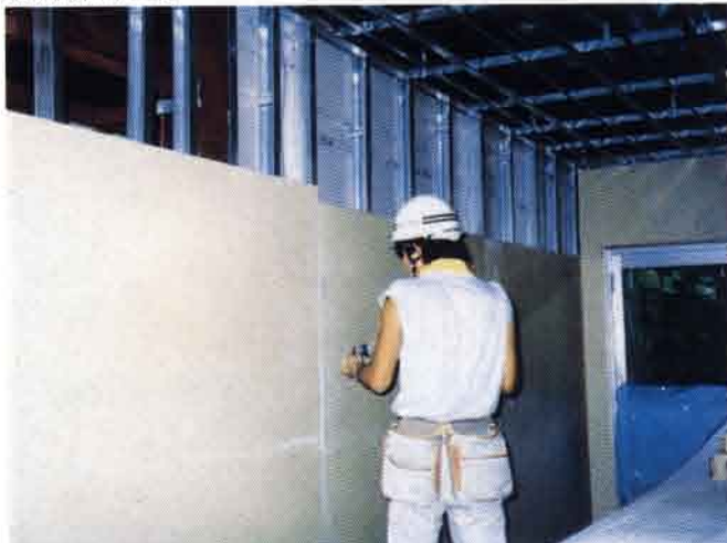
軽鉄間仕切工事
