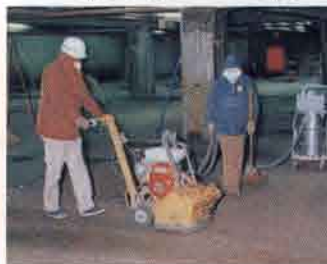
油污れ、バブサンダ掛 m 2 =1,000円 油止め接着材(塗りカチオン)m 2 =3,200円
