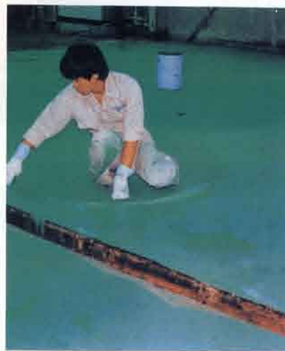
油污れ、バブサンダ掛 m 2 =1,000円 油止め接着材(塗りカチオン)m 2 =3,200円
